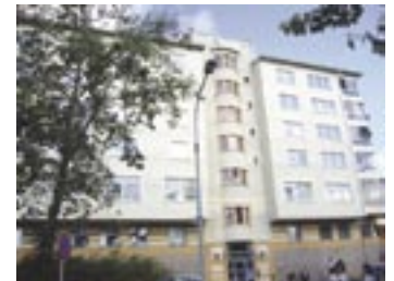
ショートステイがある高層住宅
