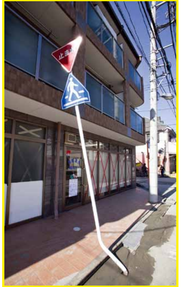
傾いた道路標識と地下から噴出した泥 (今川センター前)
