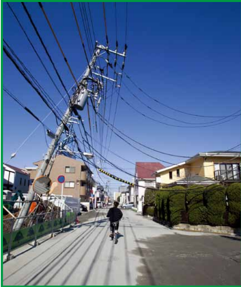
傾いた建物と電柱。電線が地面近くまで垂れ下がりました (今川センター前道路)
