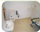
多目的 トイレ
